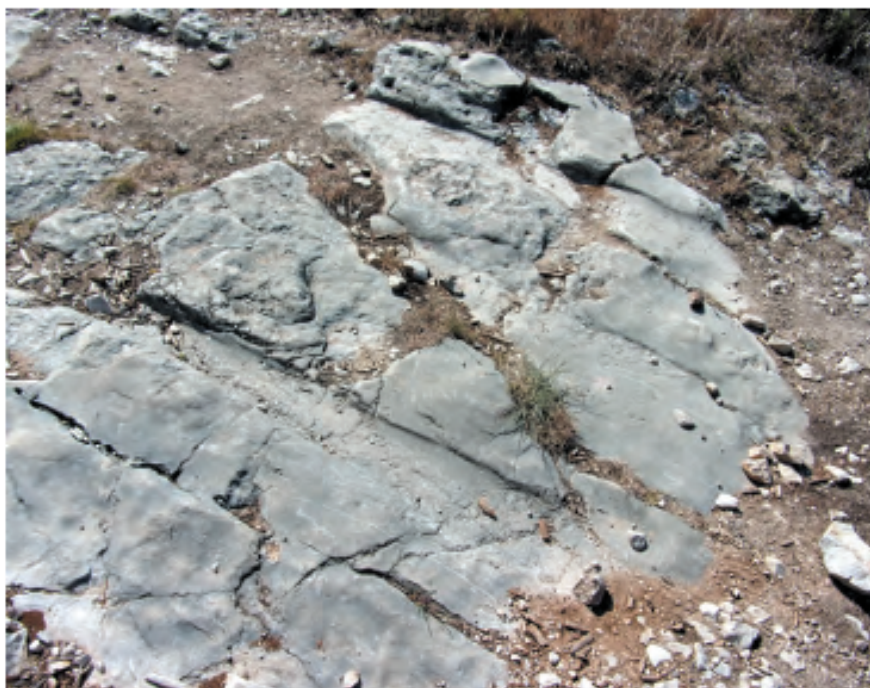
Ornières sur la voie publique
