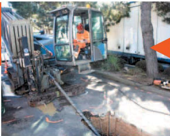
Renforcement du réseau électrique par forage dirigé, afin de minimiser l'emprise des travaux sur le boulevard de la Gare, récemment rénové par le conseil Départemental.
